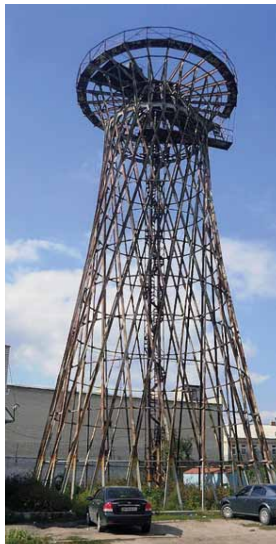
ВОДОНАПОРНАЯ ШУХОВСКАЯ БАШНЯ В ВЫКСЕ
