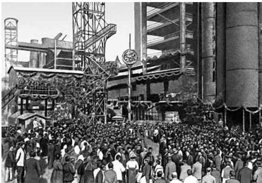
Завод Донецко-Юрьевского металлургического Общества (1896)
