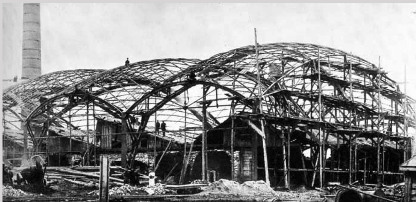
ПЕРВАЯ В МИРЕ АЖУРНАЯ КОНСТРУКЦИЯ КУПОЛА ОДНОГО ИЗ ЗАВОДСКИХ ЦЕХОВ АВТОРСТВА ШУХОВА
